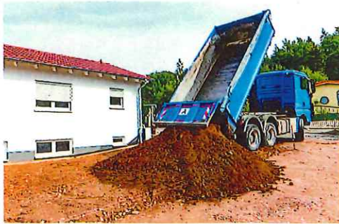
マッドスベール施工状況
