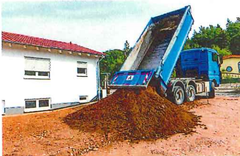
マッドスベール施工状況
